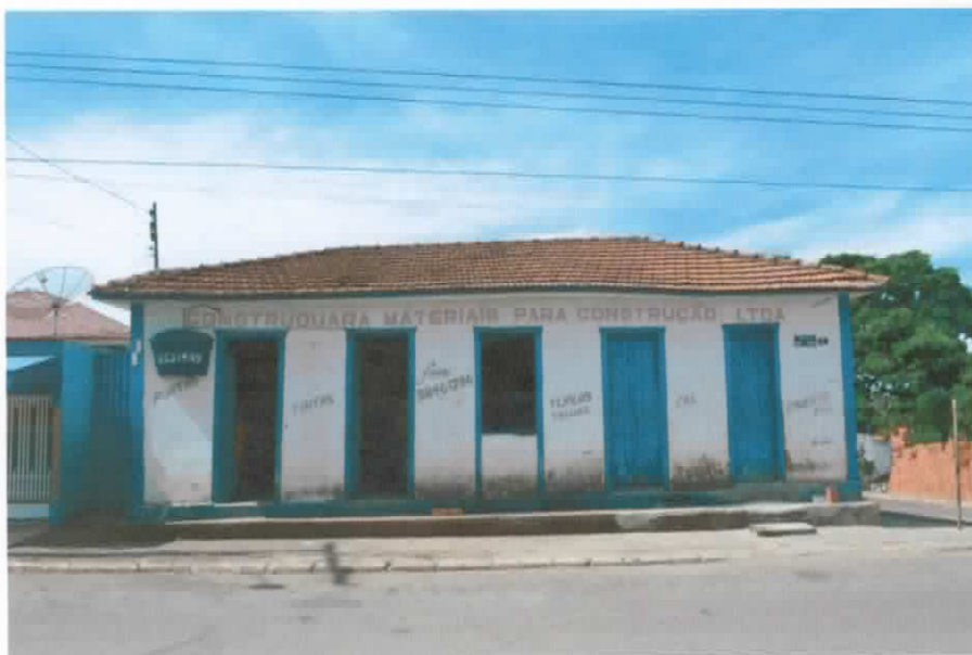
Fachada Frontal, Casarão Colonial Valdeci Pereira Maia. Fonte: Ana Paula Tavares Miranda e Guilherme Graciano, Out. 2014.
